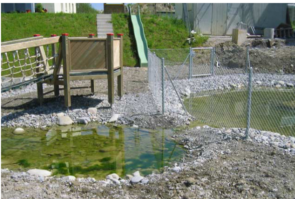
Abbildung 2 Unterteilung in einen «Spielteich» und einen durch Umzäunung gesicherten tieferen Teich
