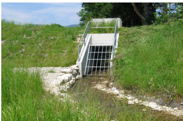
Abbildung 20 Mit einem Gitter gesicherte Eindolung
