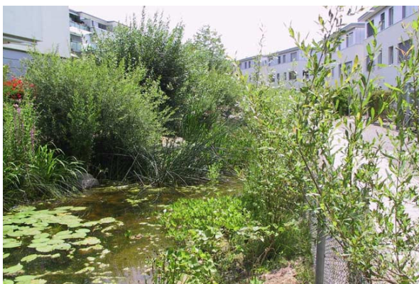
Abbildung 14 Retentionsbecken in einer Wohnanlage
