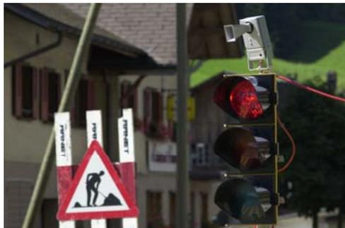
Lichtsignalanlage mit Radardetektor
