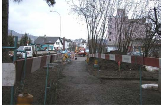
Als Abschrankung zur Führung der Fussgänger entlang der Baustelle werden rot-weiße Latten verwendet. Bei Fussgängerführungen im Bereich von Grabenöffnungen sind zwei horizontale Latten übereinander zu verwenden (Absturzsicherung für kleine Kinder).
