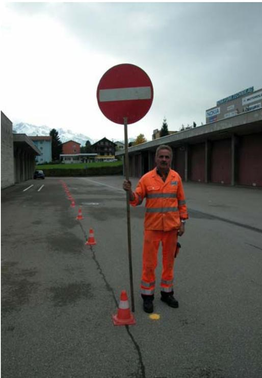
Zur Verkehrsregelung können auch Drehkellen eingesetzt werden. Bei einer kurzen Baustelle (Länge max. 20 m) und ausreichenden Sichtverhältnissen genügt der Einsatz von einer Drehkelle. Bei längeren Baustellen sind zwei Drehkellen zu verwenden. Die beiden Personen müssen sich sehen oder sich miteinander verständigen können (z. B. Funk).
