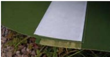
**Schritt 2:** Die zusammen geklebten Enden in Z form, wie gezeigt, umbiegen. Einen dritten Klebestreifen aufbringen, ohne die obere Schutzabdeckung abzunehmen.
