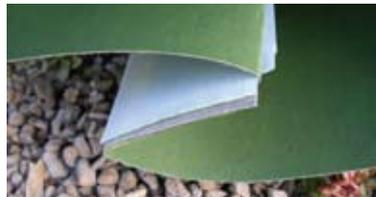
**Schritt 3:** Nachdem die Form zurechtgebogen wurde, die restlichen Schutzabdeckungen abnehmen und die Enden fest zusammenpressen. Durch diese Verbindung wird keine Wurzel mehr durchdringen können.
